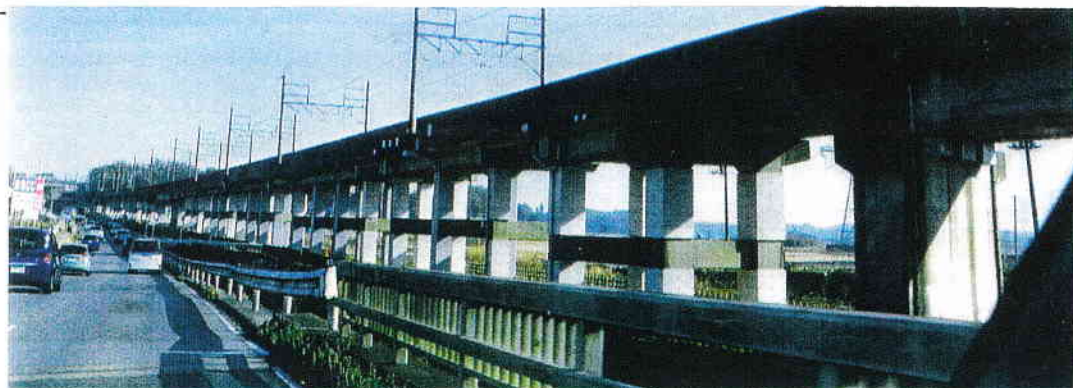
小室駅近くの北総線の陸橋。北総線の線路を京成線が通る際に、線路使用料を北総鉄道に支払っていないことが、北総線高額運賃の原因になっている。
